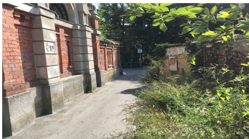
2016: IST-Zustand nach Abriss der Stallungen der Parksaua
